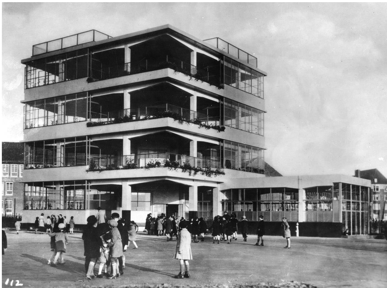
Cliostraat Openluchtschool, Ark Jan Duiker (1927-1930)
